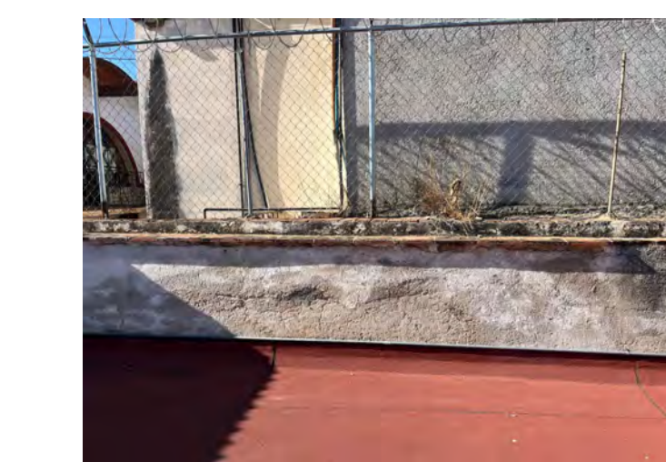
F07. Presencia de humedad y desprendimiento parcial de aplastados en pretilles de losa de azotea.
