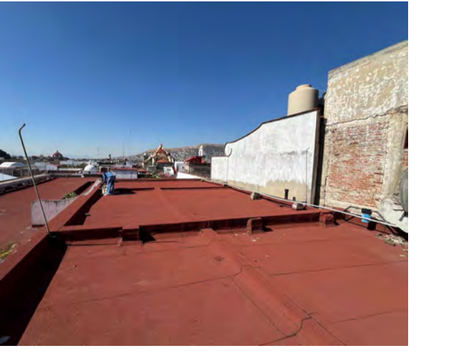
F07. Losas de azotea de concreto armado con espesor promedio de 12 cms y prells de ladrillo de barro rojo recocido forradas con impermeabilizante de carpeta asfáltica APP.
