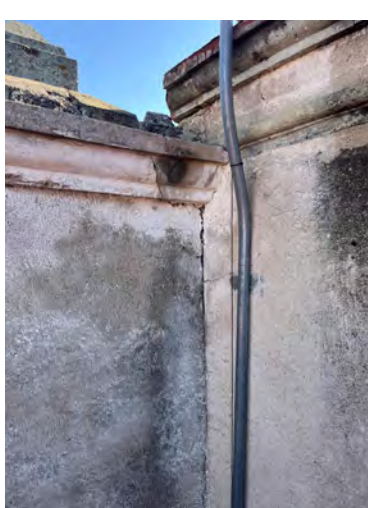
F01. Grieta en muro y desprendimiento parcial de aplastado, así como fractura de cornisa y manchas de humedad.
