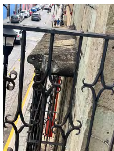
F03. Fractura, faltante de piezas y disgregación de juntas en cornisa superior de esquina de balcon de piedra cantera provocado por la falta de mantenimiento, así como presencia de manchas de humedad por escurrimiento de aguas pluviales.
