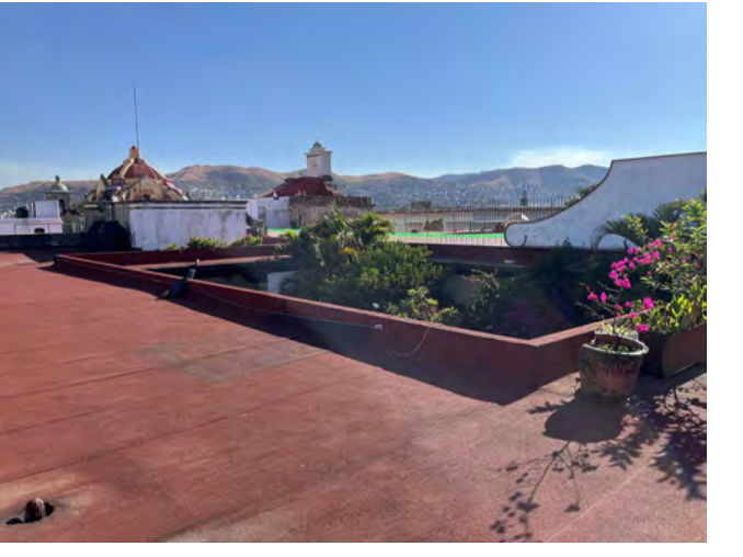
F03. Losas de azotea de concreto armado con espesor promedio de 52 cms y prells de ladrillo de barro rojo recocido forradas con impermeabilizante de carpeta asfáltica APP.
