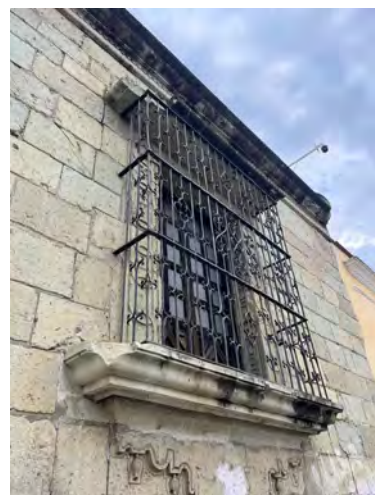
F01. Fractura, faltante de piezas y disgregación de juntas en cornisa base y de esquina de ventana de piedra cantera provocado por la falta de mantenimiento, así como presencia de manchas de humedad por escurrimiento de aguas pluviales.
