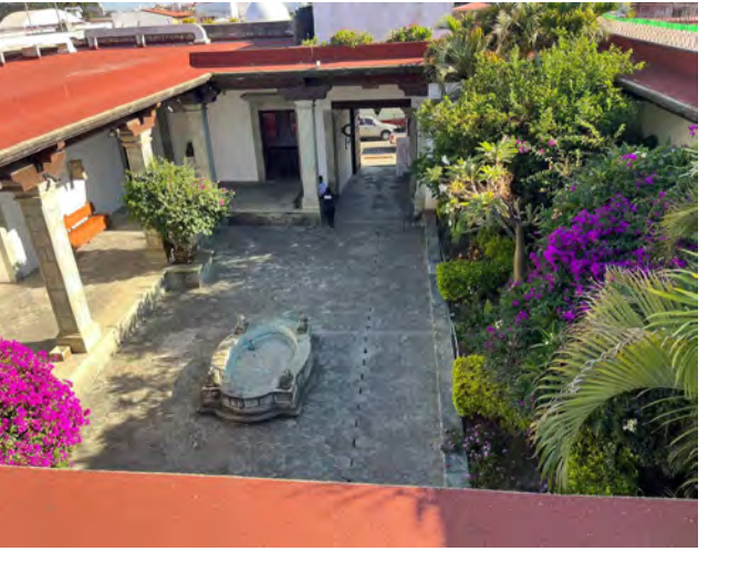
F04. Losas de azotea de concreto armado con espesor promedio de 38 cms y prells de ladrillo de barro rojo recocido forradas con impermeabilizante de carpeta asfáltica APP. En la parte inferior fuente de cantera y patio con piso de adoquín hexagonal de cantera verde de 16 cms aprox por cara.
