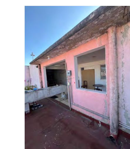
F06. Presencia de salitre en muros y losa de azotea causando desprendimiento de aplastados y pintura vinílica en muros, causados por humedad, filtración de agua pluvial y falta de mantenimiento.
