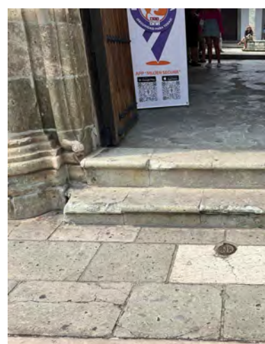
F04. Fractura, faltante de piezas y disgregación de juntas en escalones de piedra cantera provocado por la falta de mantenimiento.
